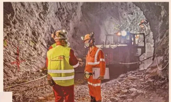
En DSI Underground trabajan estrechamente con sus clientes, para entender de forma integral las problemáticas que plantea cada proyecto.
